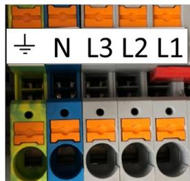
Bornes de raccordement de l'aérotherme
