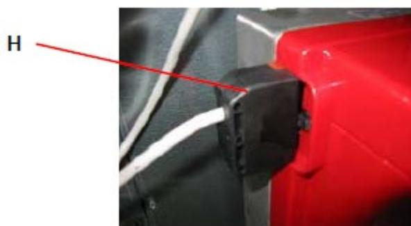
Ôter le couvercle du brûleur et régler le pressostat de l'air sur la valeur indiquée dans le Tableau des caractéristiques techniques du Manuel d'Utilisation ;
