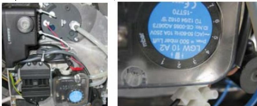
Régler le pressostat du gaz sur 75 % de la pression d'alimentation ;
