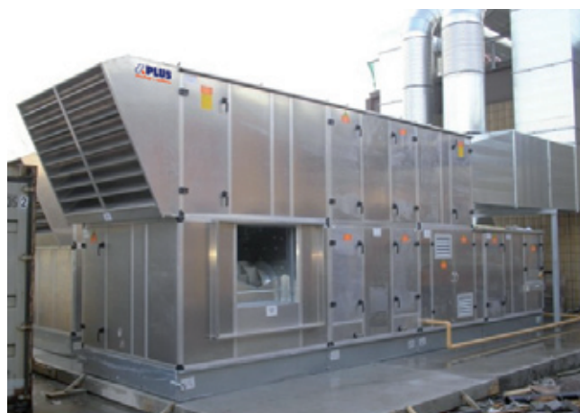
Échangeur rotatif à haut rendement (jusqu'à 90%)
